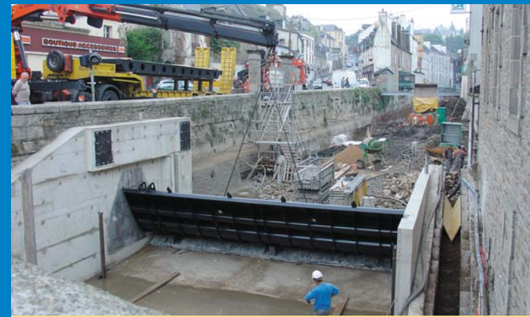
La pose du clapet mobile
