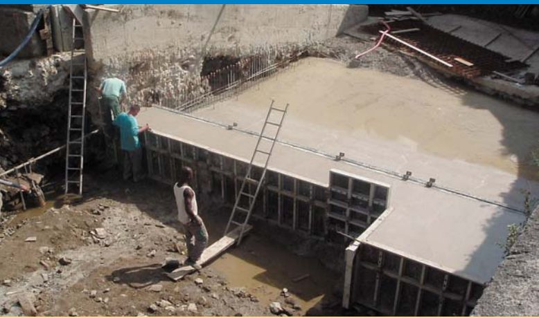
Les fondations du clapet
